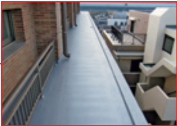
ルーフバルコニー 屋外・屋内防水工法②・③・④ (P10・12・14) 通気緩衝工法 (MT) (P18)
