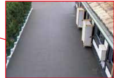
開放廊下 (側溝+幅木) タキストロンとの 複合防水システム (P26)
