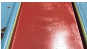
プライマー塗布
