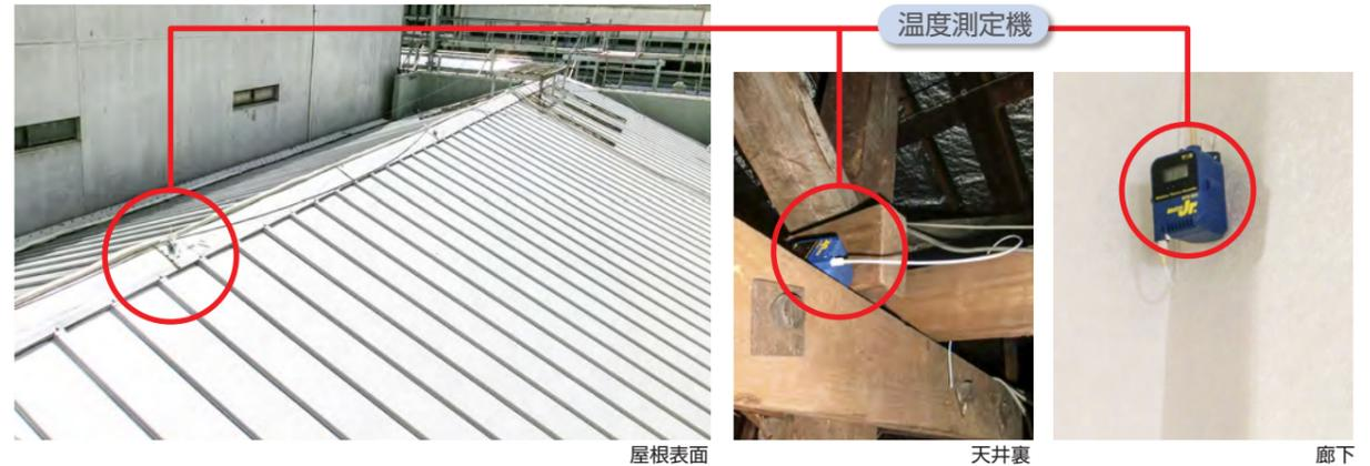
金属屋根に遮熱仕様のBR工法を施工し、施工前と施工後の屋根の表面・天井裏・廊下の温度を測定。
