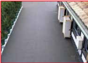
開放廊下 (側溝+幅木) タキストロンとの 複合防水システム (P26)
