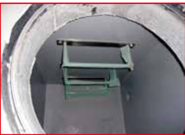
雨水貯留槽 水槽類・地下防水工法 (P22)
